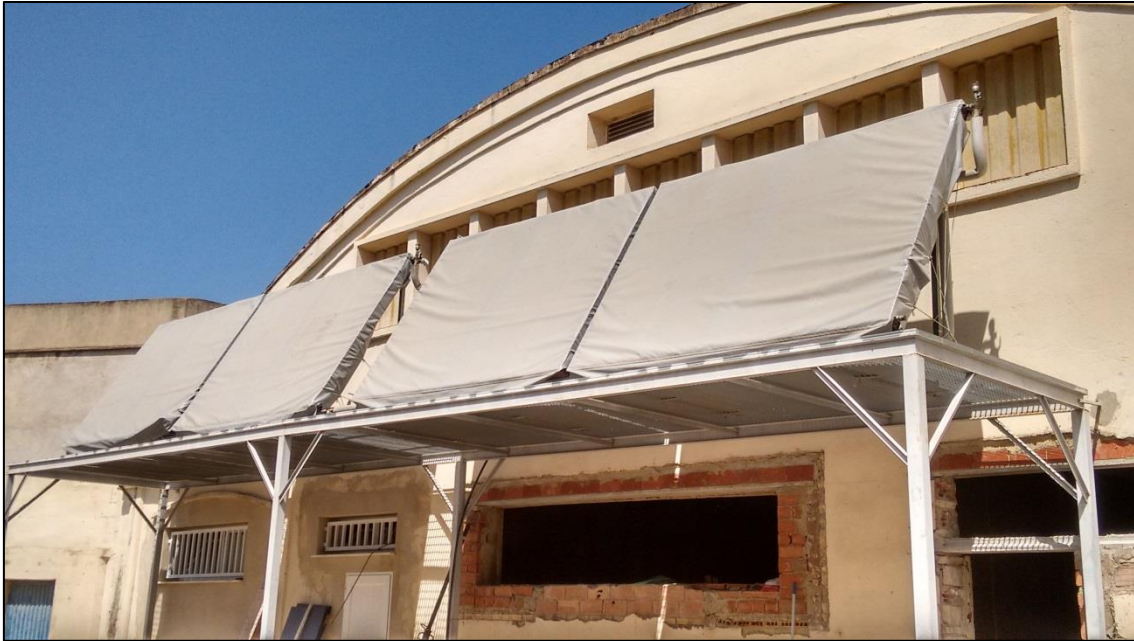
Fotografia 3: Panells solars instal·lats per al sistema de calefacció de l'IES Sant Vicent Ferrer d'Algemesí. Font: Elaboració pròpia.
