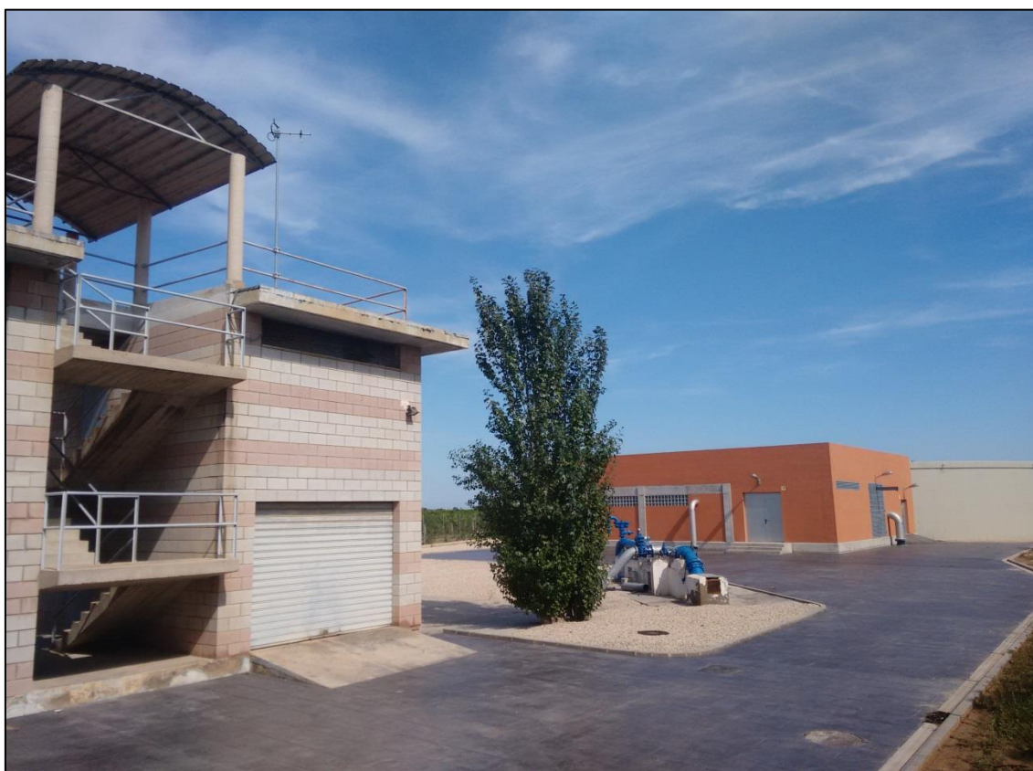
Fotografia 1: Instal·lacions del pou d'abastiment urbà. Font: Elaboració pròpia.
